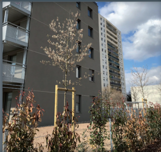
78 logements passifs, quartier Europe à Colmar (68) © Richter Architectes & Associés
